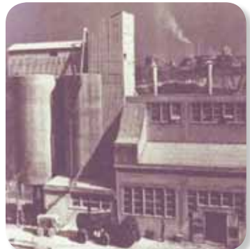
Nieistniejąca już dziś przemiałownia fot. Archiwum CEMEX
